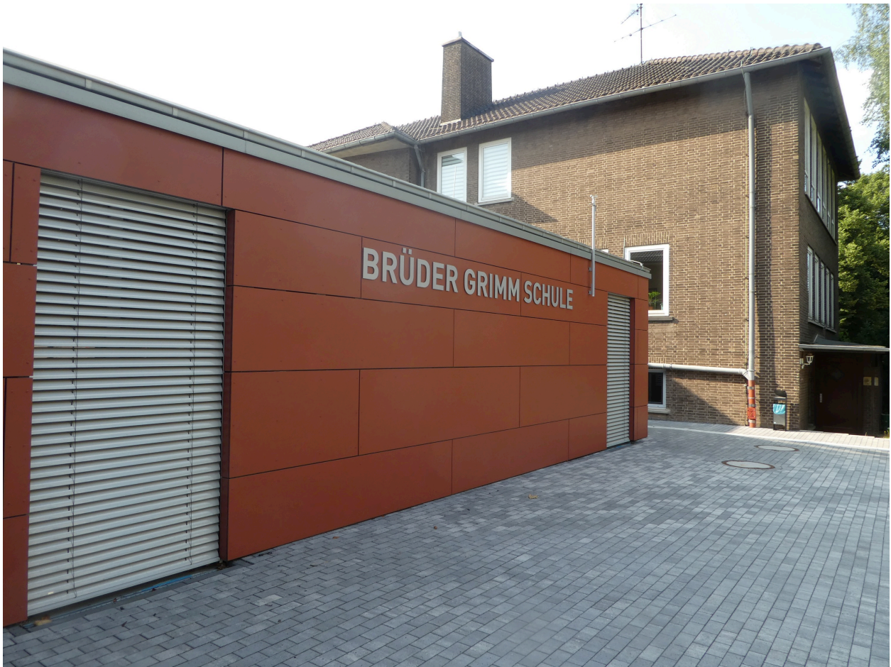
Fotos von dem Besuch der Großbaustelle an der Brüder Grimm Schule:
